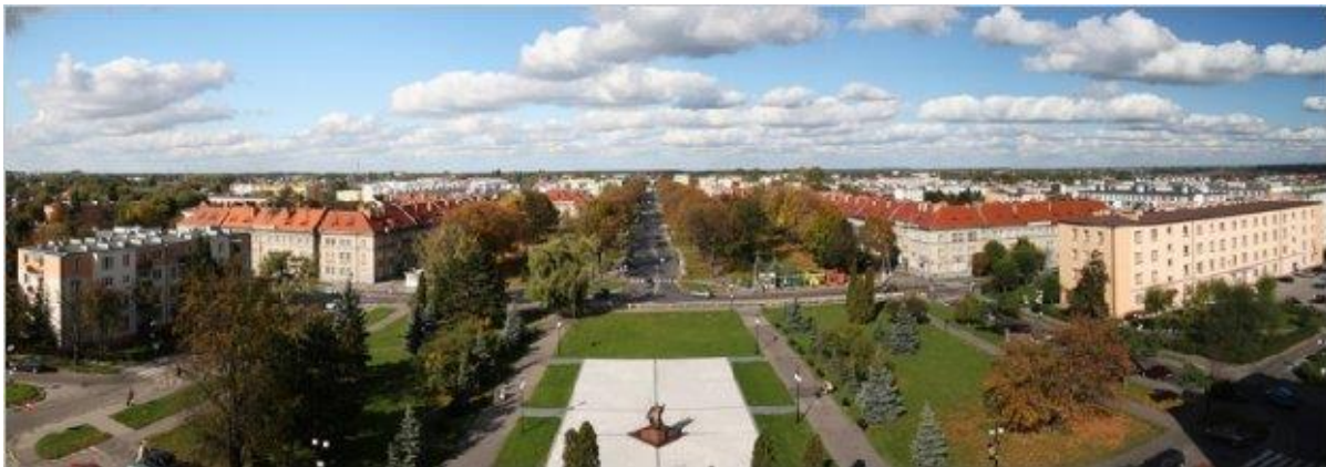
Fotografia 5. Dzielnica Kolejowa „Dyrekcja” w Chełmie
